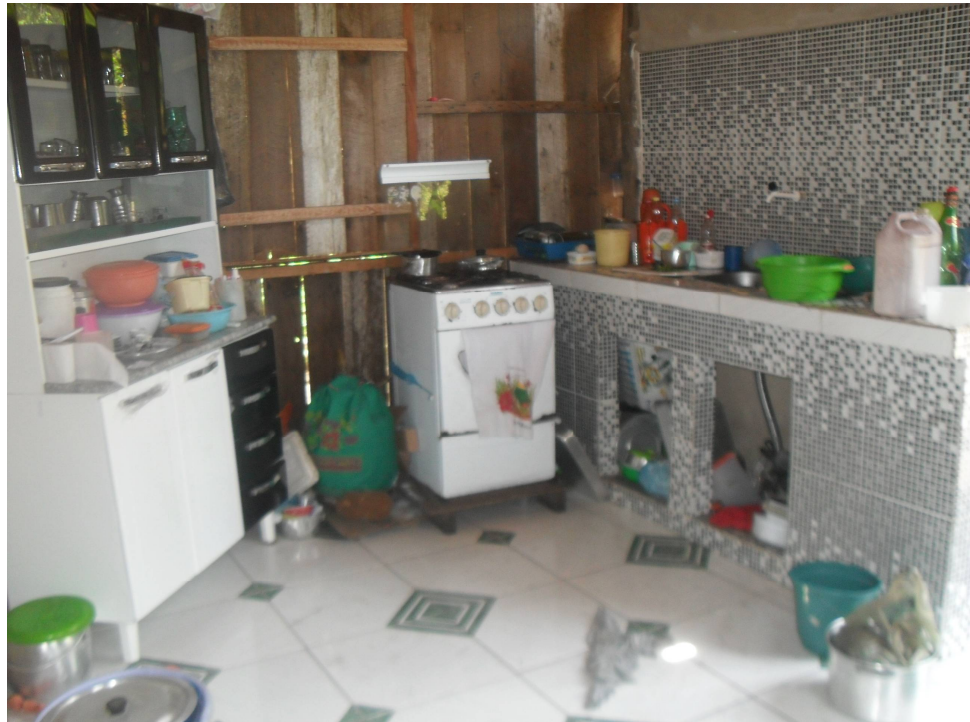
Figura 9: Casa de um morador quilombola mostrando a melhoria das instalações de sua cozinha. Notar as lajotas no chão. Enquanto as paredes ainda são de madeira para melhorar a ventilação.
